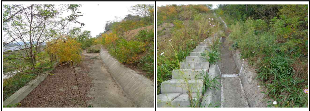
【그림 9.3.3】 배수시설 전경
